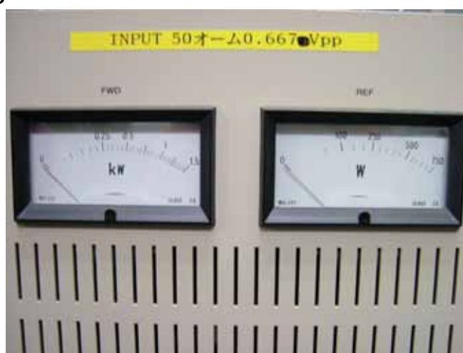
Fig.3-7 高周波電源のパワーモニタ
